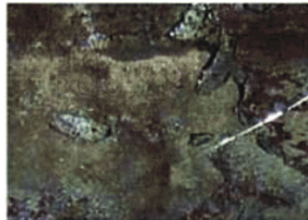
Edge cracking
